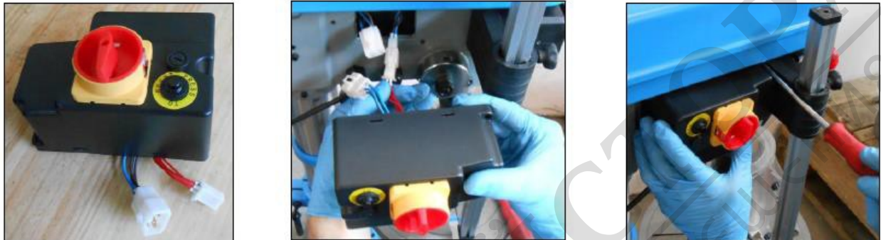
Фигура 7 – Фази на монтажа на електрическото табло
