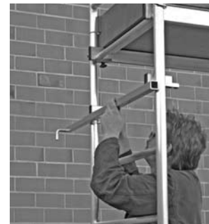
Grundgerüst mit erster und zweiter Aufstockung
